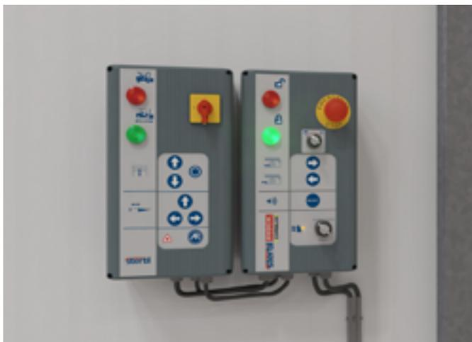
Die Kontrollleuchte des COMBILOK® G<sup>2</sup>-Bedienfelds leuchtet grün, was bedeutet, dass das Fahrzeug durch das G<sup>2</sup> sicher verriegelt ist. Die Kontrollleuchte der Überladebrücke leuchtet ebenfalls grün, was bedeutet, dass die Überladebrücke in Position ist und das Be- oder Entladen unter sicheren Bedingungen beginnen kann.
