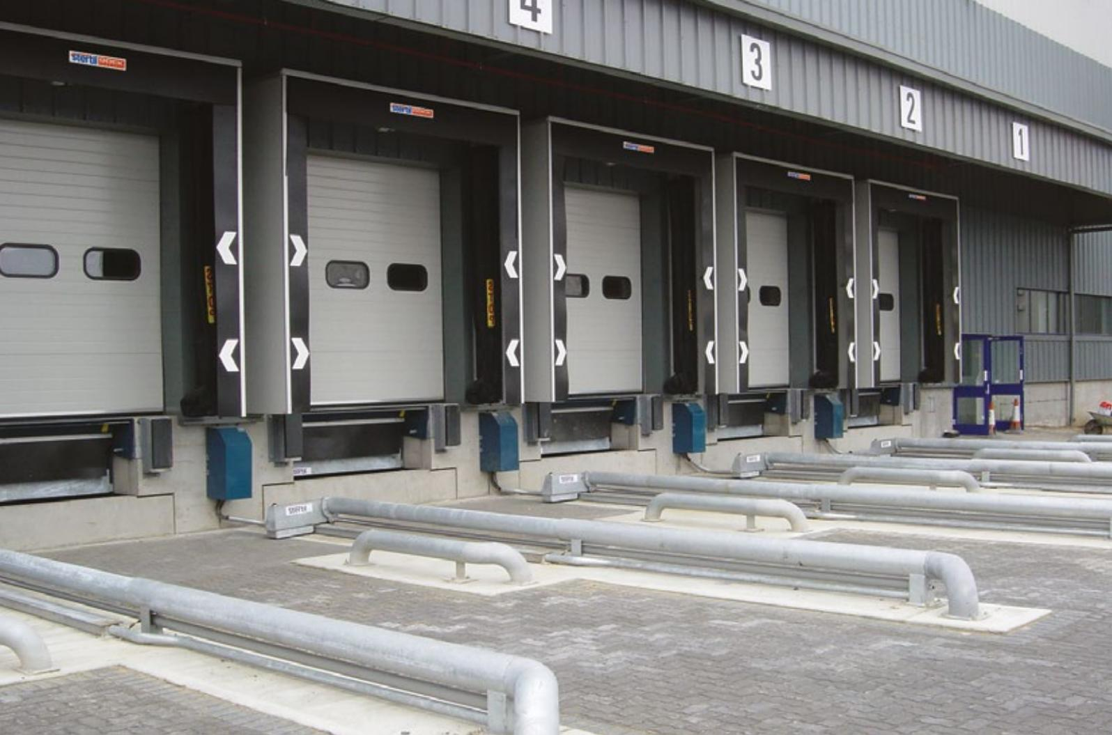
Bei der Verwendung einer Kissentorabdichtung entspricht die Torbreite dem Innenmaß der Torabdichtung. Das Maß der Torabdichtung ist wiederum abhängig von den LKW-Maßen. Die Höhe der Toröffnung ist abhängig von der maximalen LKW-Höhe (3.800 – 4.200 mm). Empfohlen wird, der maximalen Höhe einen Sicherheitspielraum hinzuzufügen. Ausgehend von einer Rampenhöhe von 1.250 mm sollte ein Tor von 3.000 mm ausreichen.
